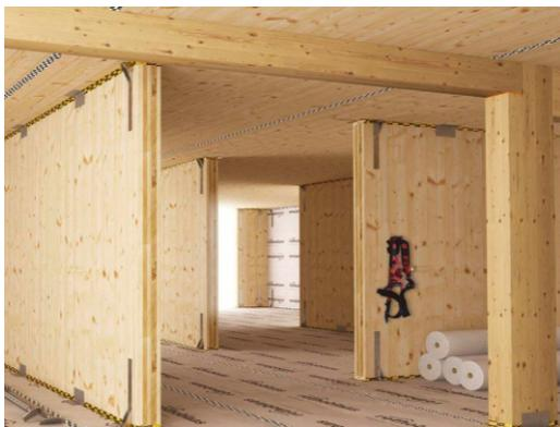
*Ilustración 2. Ejemplo de estructura de entramado Macizo con paneles de CLT. Fuente: Rothoblaas*
